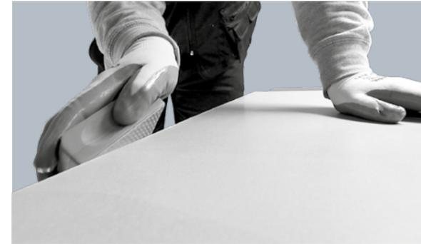
8 Die Kanten können manuell mit Hilfe von Diamantschwämmen oder Schleifpapier nachgearbeitet werden. Mit einem leichten Durchgang am Plattenrand kann ein Stumpfschliff und mit wiederholten Durchgängen eine Schräge erzielt werden.
