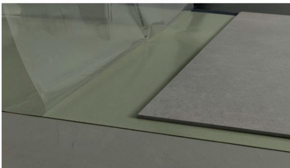
Schutzfolie NICHT ganz abziehen, sondern erst nach und nach während der Verlegung der Kerlite-Platten entfernen.
