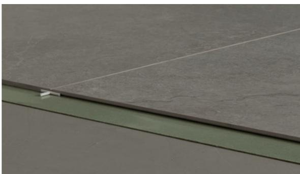
Zuschneiden. An den Außenrändern ist ein Abstand von den Wänden von circa 5 mm einzuplanen. Diese Randfuge wird anschließend durch die Sockelleiste abgedeckt oder wie eine normale Fuge mit Silikon gefüllt.
